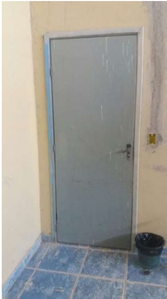
Porta da sala de música a ser trocada
