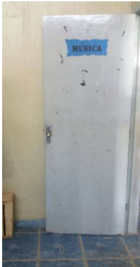
Porta da sala de música a ser trocada
